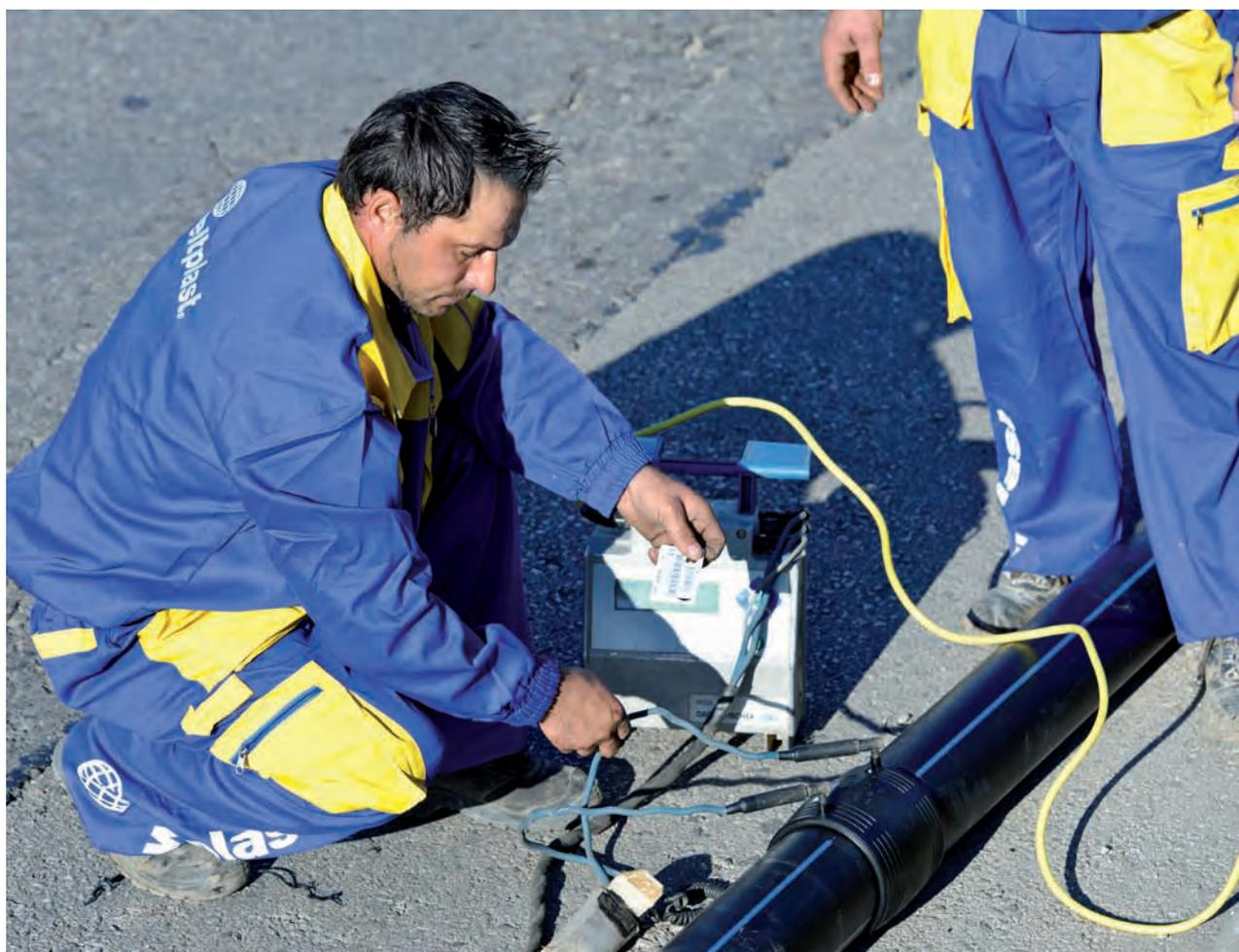
SLIKA 3.14. Elektrofuzijsko zavarivanje
