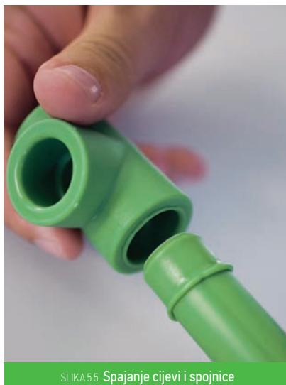
SLIKA 5.5. Spajanje cijevi i spojnice
