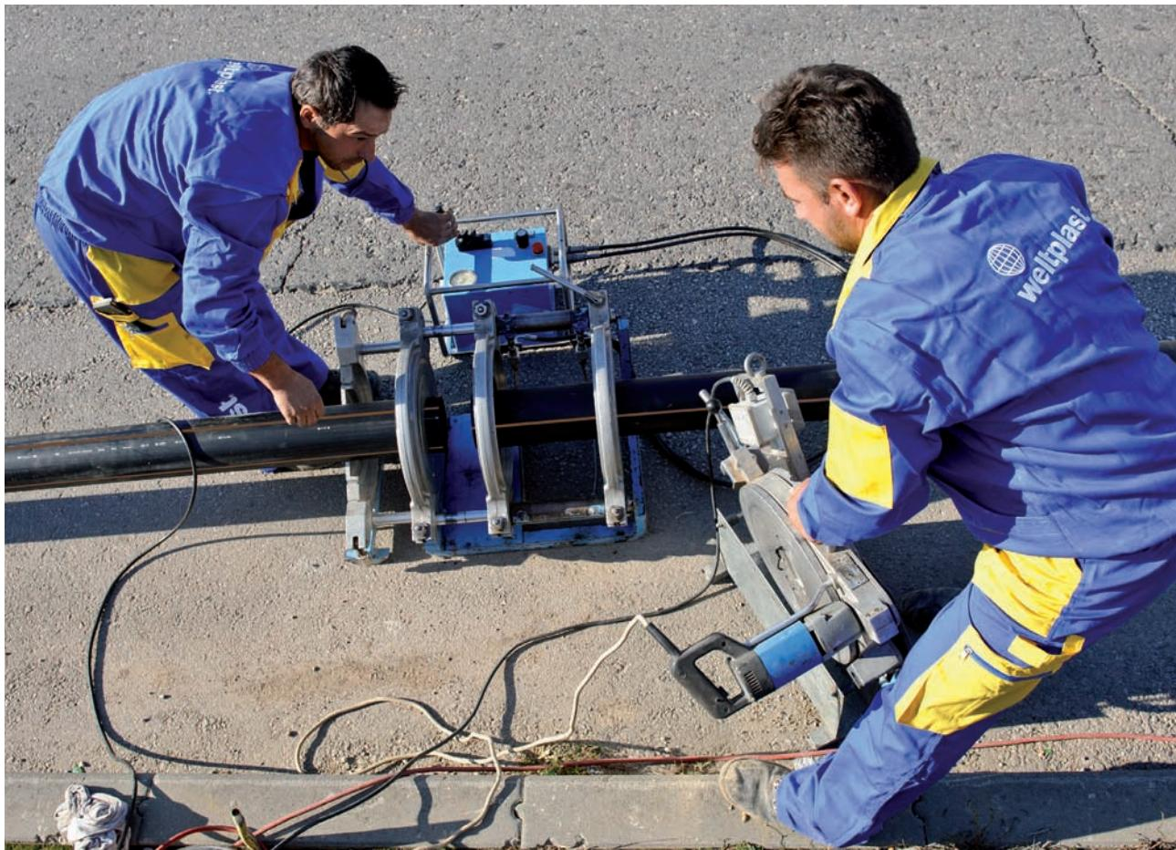
SLIKA 3.13. Sučeno zavarivanje cijevi
