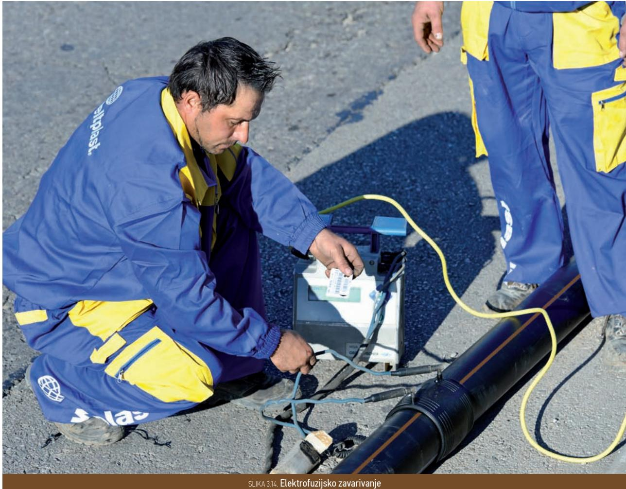
SLIKA 3.14. Elektrofuzijsko zavarivanje
