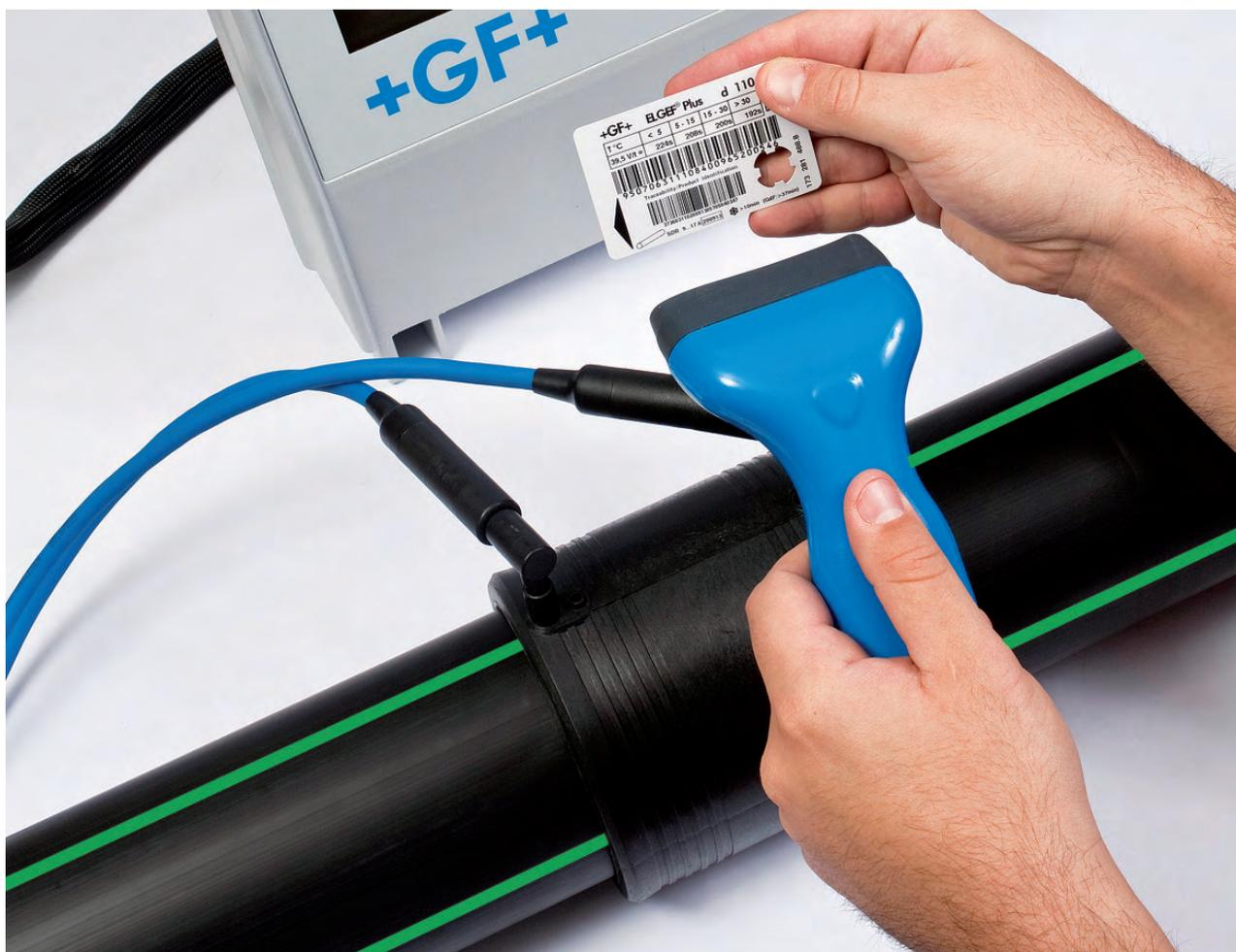
SLIKA 8.13. Elektrofuzijsko zavarivanje
